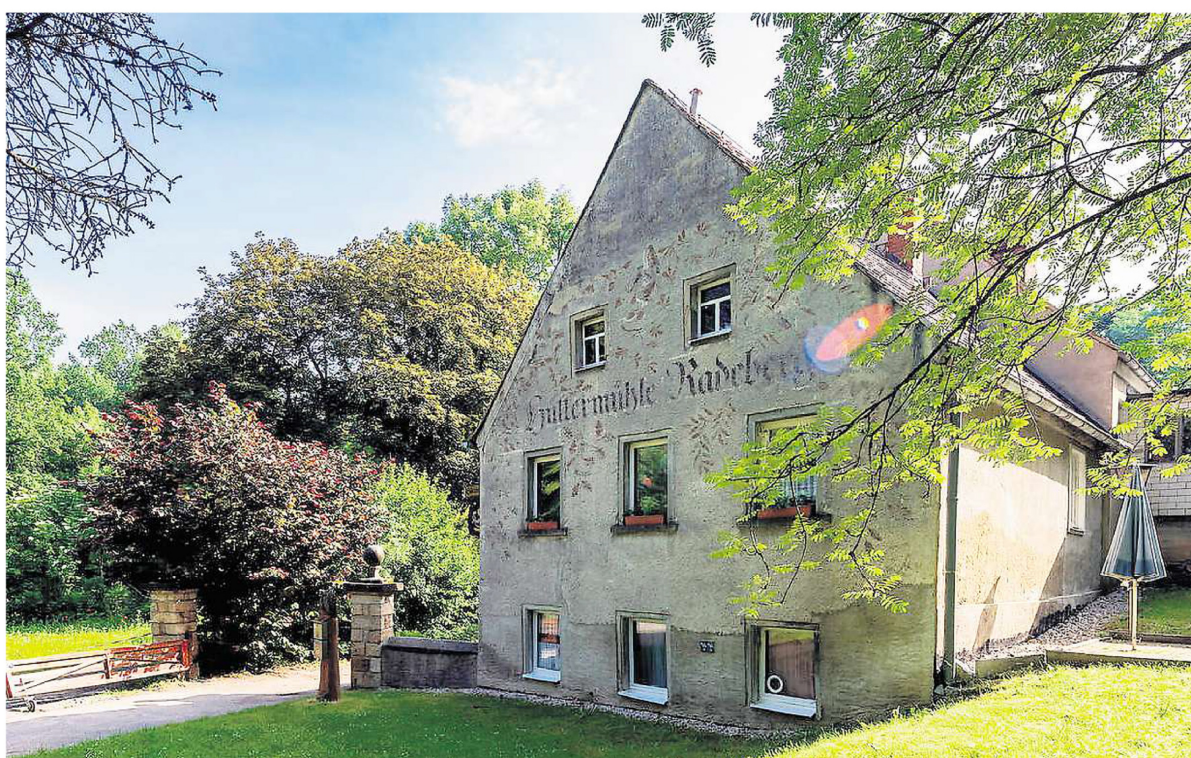
Wartet weiter auf die dringend notwendige Sanierung: die Hüttermühle im Hüttertal
